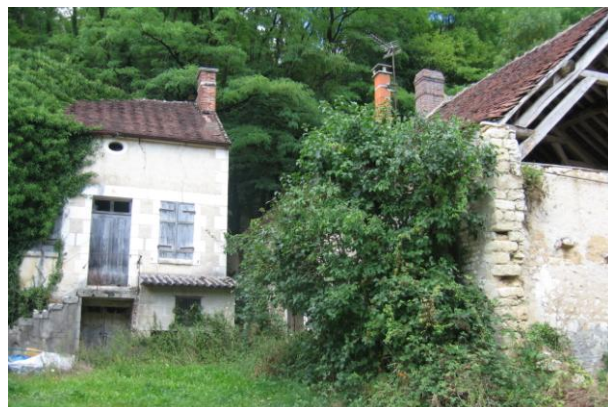
Constructions sur le hameau de Montallery
